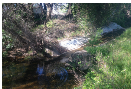
Pequeno Creek spillway
